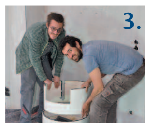
1. Wie Lego: Die einzelnen Teile werden in der Werkstatt auf die passende Größe ausgeschnitten und zusammengeklebt. Dann brauchen sie »nur« noch zusammengesetzt zu werden. 2. Steht der Ofen auch wirklich gerade? Ulrich König schaut nach. 3. Die Ofenbauer bringen den zweiten Ring der Außenwand an. 4. Reihe um Reihe mörtelt Ulrich König den Kern des Ofens. 5. Der Kern des Ofens besteht aus Schamottsteinen. Diese speichern die Wärme. 6. Hat man auch sauber gearbeitet? Passt die Kachel-Hülle um die Ofentür?
