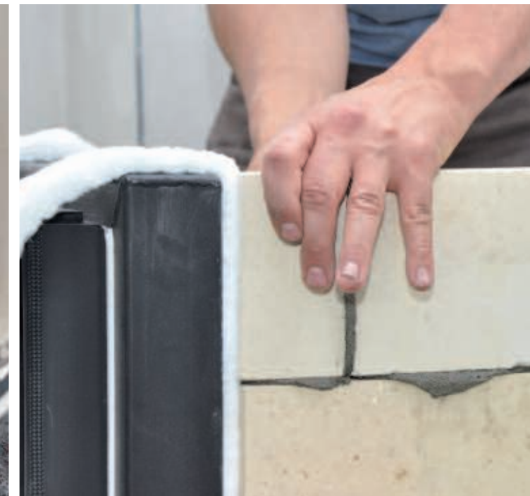
Die Keramikfaser sorgt dafür, dass zwischen Ofentür und Steinen auch wirklich alles dicht ist.
