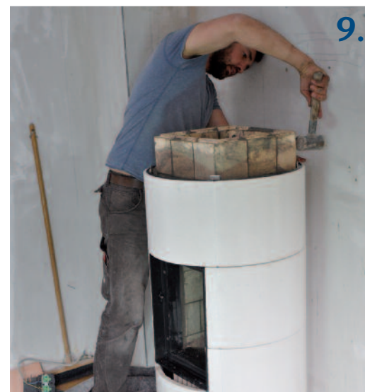
7. Ja, sie passt. 8. Ring um Ring des Ofenaußenmantels wird angebracht. 9. Immer wieder schauen, ob auch alles gerade ist. 10. Der letzte Ring. 11. Jetzt noch das Ofenrohr. 12. Und fertig! Hausherr Michael Pfister zündet seinen Ofen zum ersten Mal an.
