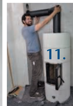
7. Ja, sie passt. 8. Ring um Ring des Ofenaußenmantels wird angebracht. 9. Immer wieder schauen, ob auch alles gerade ist. 10. Der letzte Ring. 11. Jetzt noch das Ofenrohr. 12. Und fertig! Hausherr Michael Pfister zündet seinen Ofen zum ersten Mal an.
