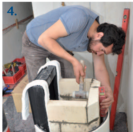
1. Wie Lego: Die einzelnen Teile werden in der Werkstatt auf die passende Größe ausgeschnitten und zusammengeklebt. Dann brauchen sie »nur« noch zusammengesetzt zu werden. 2. Steht der Ofen auch wirklich gerade? Ulrich König schaut nach. 3. Die Ofenbauer bringen den zweiten Ring der Außenwand an. 4. Reihe um Reihe mörtelt Ulrich König den Kern des Ofens. 5. Der Kern des Ofens besteht aus Schamottsteinen. Diese speichern die Wärme. 6. Hat man auch sauber gearbeitet? Passt die Kachel-Hülle um die Ofentür?
