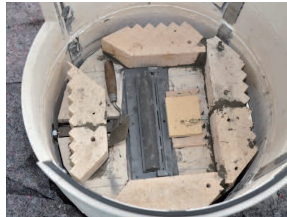
Im untersten Ring befindet sich die wichtige Lufklappe.
